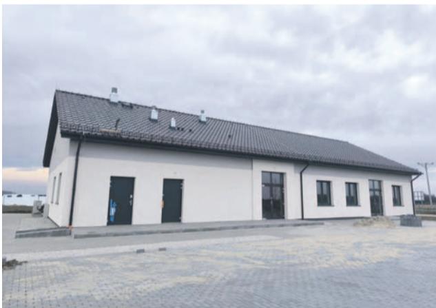
Świetlica w Marszowicach
