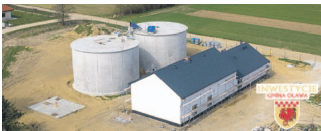
Stacja Uzdatniania Wody w Siedlcach
