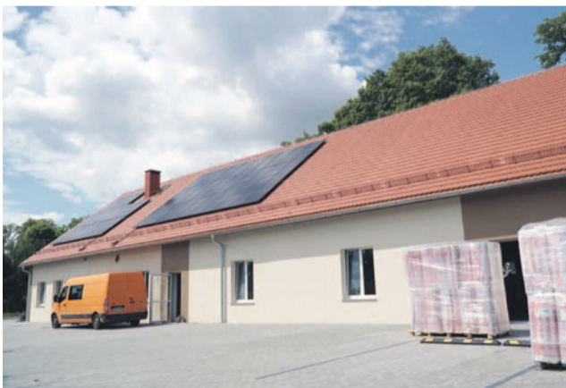
Świetlica w Jaczkowicach
