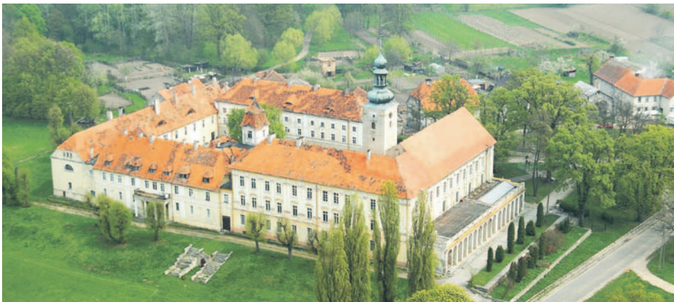
Pałac w Oleśnicy Małej
