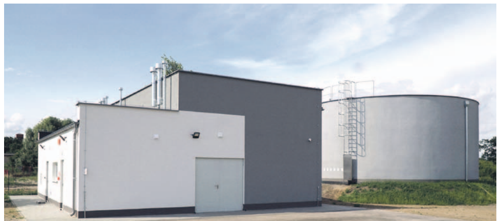
Stacja Uzdatniania Wody w Sobocisku
