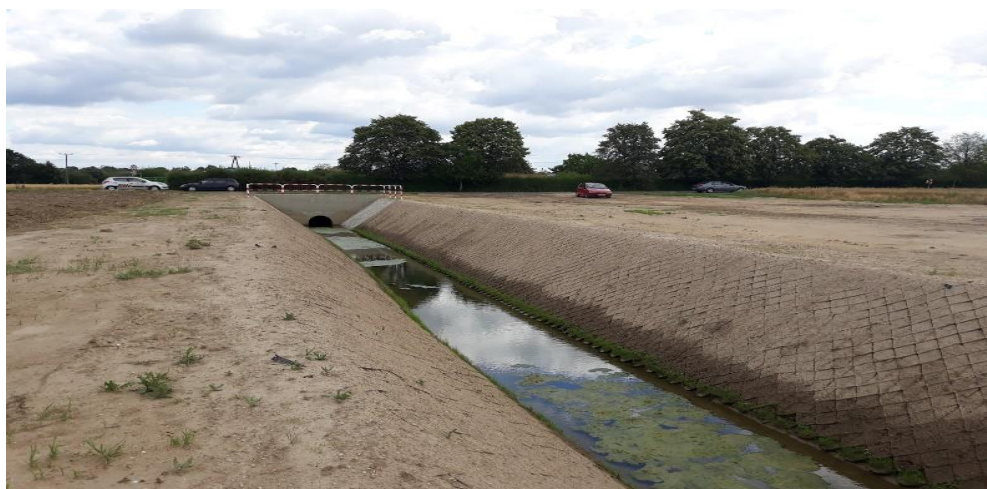
Budowa sieci kanalizacji deszczowej - Osiedle Nowy Otok Wschód Etap I - rów retencyjny
